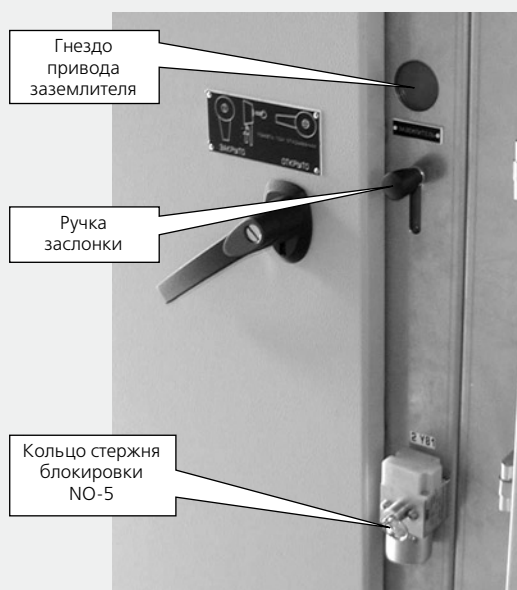
Рис. 23. Электромагнитная блокировка привода заземлителя
