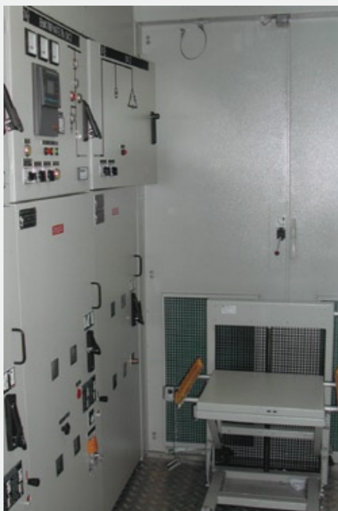
Рис. 4. Комплектное распределительное устройство D-12PT в модульном контейнере
