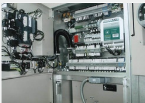
Рис. 8. Отсек вспомогательных цепей
