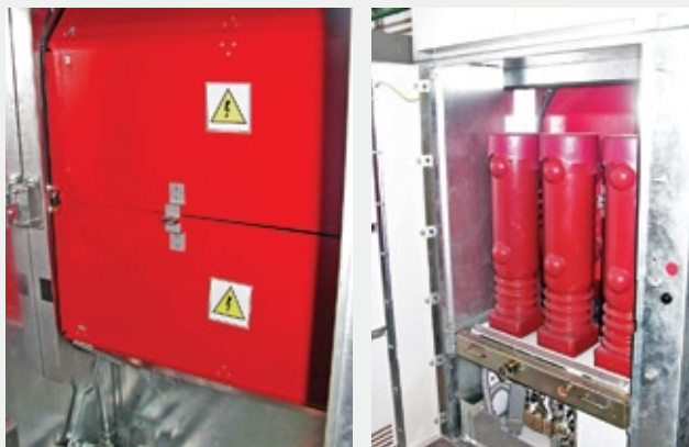
Рис. 7 Отсек выдвижного элемента
