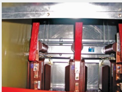
Рис. 11 Отсек присоединений.
