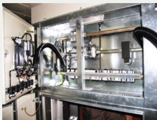
Рис. 12 Отсек вспомогательных цепей.
