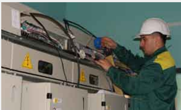
Рис. 5.14. Прокладка транзитных цепей
