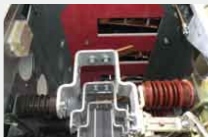
Рис. 5.8. Отсек присоединений
