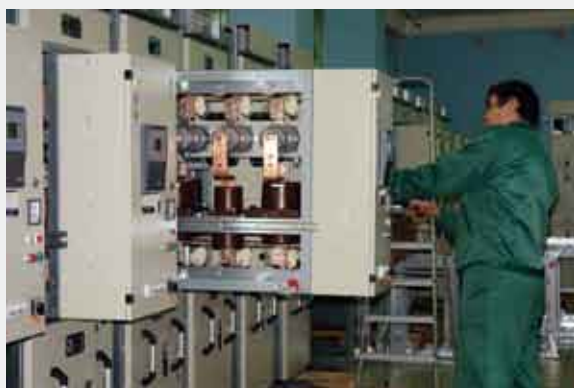
Рис. 5.3. «Ремонтное» положение моноблока
