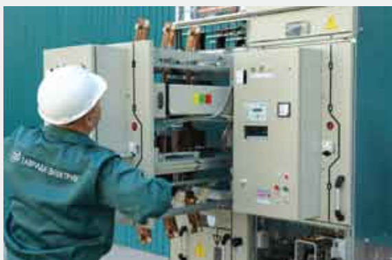
Рис. 5.4. Шинный и линейный разъединители
