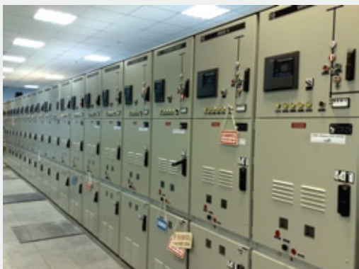
Рис. 3. Комплексное распределительное устройство промышленного предприятия
