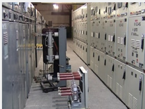
Рис. 2. Реконструкция распределительного устройства (слева — традиционное КРУ с нижним расположением ВЭ; справа — КРУ серии D-12P со средним расположением КВЭ)
