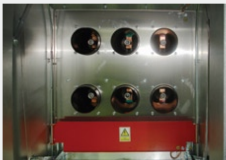
Рис.7 Отсек выдвижного элемента и защитные шторки
